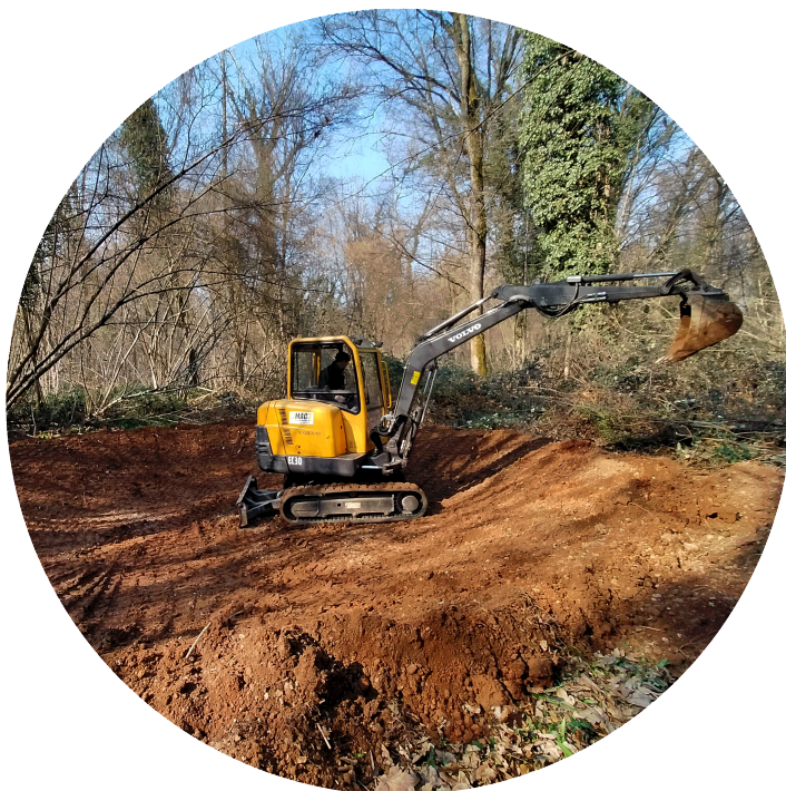
Realizzazione di una pozza artificiale
